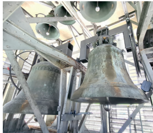
Die neuen gekröpften Glockenjoche, die Glockenaufhängungen, die neuen Läuträder und die neuen Klöppel sind auf dem Bild gut zu erkennen. Der Glockenstuhl und die Glocken selbst sind in ursprünglichem Zustand.
